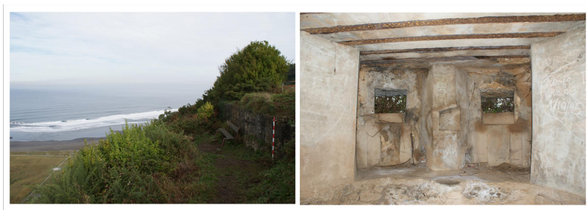
Fig. 12.- Posición fortificada republicana guardando la desembocadura del río Nalón en las proximidades de San Juan de la Arena
