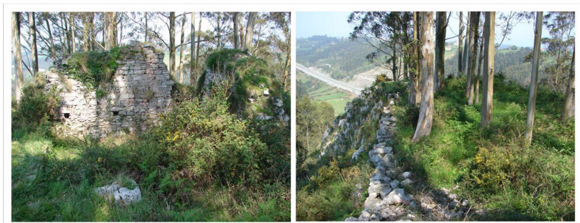
Fig. 3.- Estructuras constructivas en la cima del Pico Las Torres: (a) torre central de la plataforma y (b) muro de cierre perimetral
